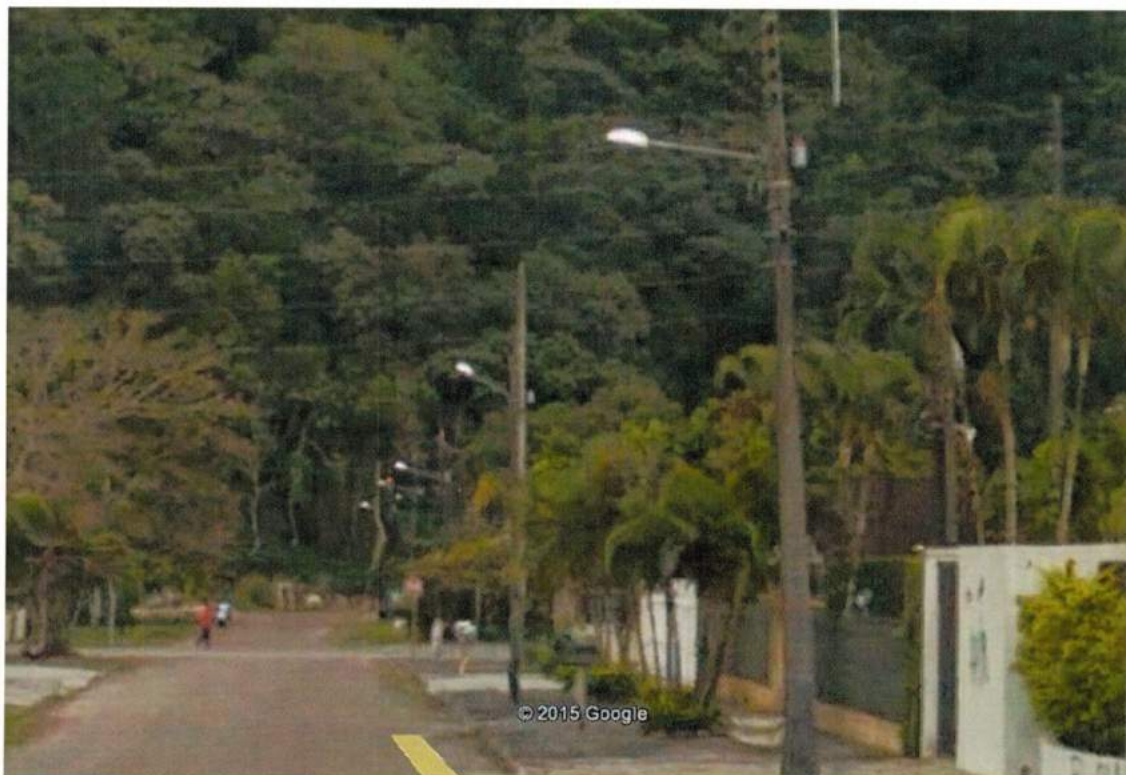
Figura 6 – Luminária Aberta com Reator Externo
